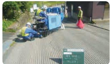
グルービングとは、滑り止めとして舗装面に3~4mmの溝を切削施工すること又その工法のことです。
