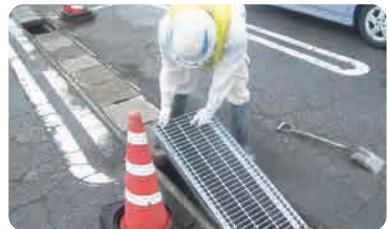
舗装或いは、側溝・L型擁壁等の一般土木工事も施工しております。身近な所では、グレーティングの布設替えや、駐車場の舗装等も幅広く行っております。
