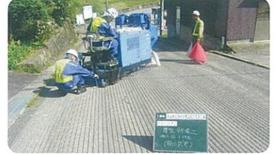
グレーピングとは、滑り止めとして舗装面に3～4mmの溝を切削施工すること又その工法のことです。
